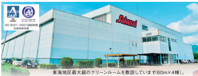
東海地区最大級のクリーンルームを敷設しています(60m×4棟)。
