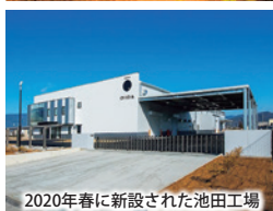
2020年春に新設された池田工場
