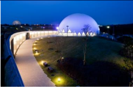
総合建設業 【大垣市】
